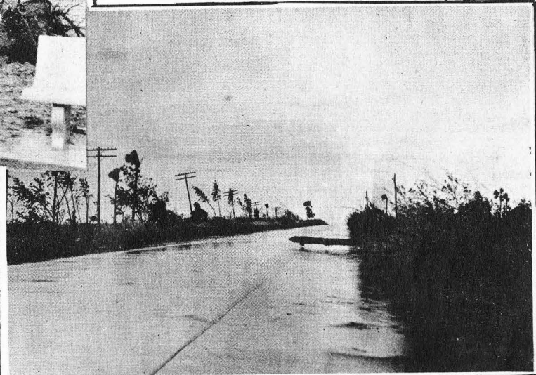
ENTRONQUE. —Los postes del telégrafo derribados sobre la carretera central, a poca distancia del entronque de Puerta de Golpe.
